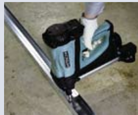
●軽天材の留め付け
